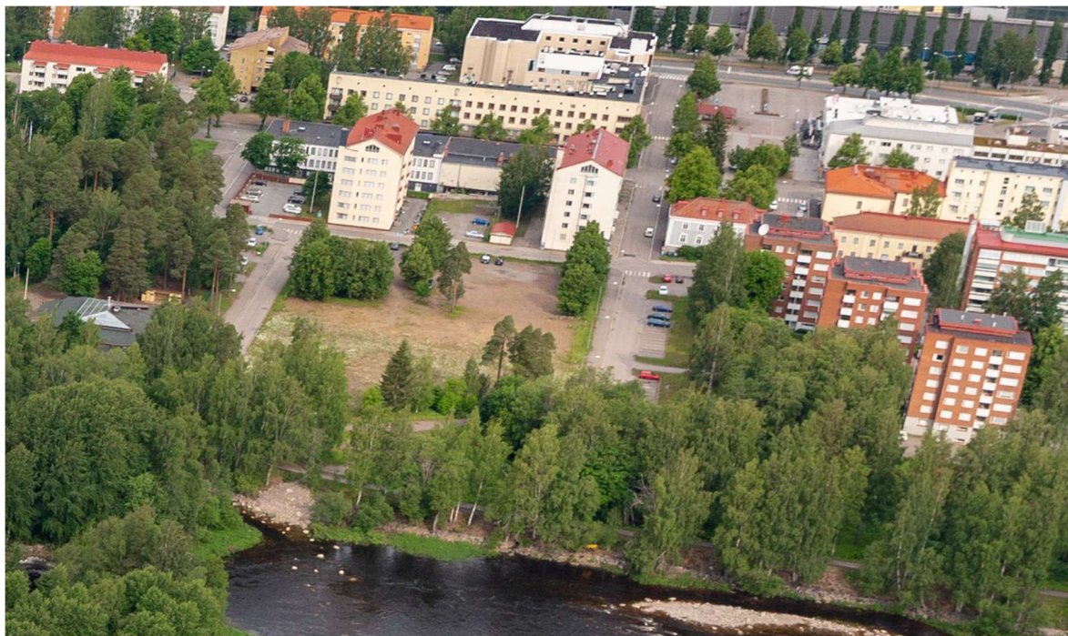
Kuva 24: Yleiskuva alueen rakennuskannasta
